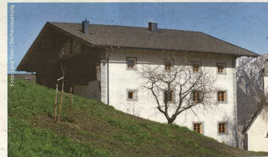
Mit Hilfe der Dorferneuerung erstrahlt der Kollreider Hof in Anras in neuem Glanz.
